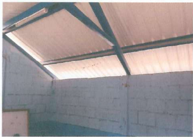
Foto1: Mejoramiento de pared de aula.
