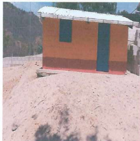
Foto 2: Mejoramiento de estructura y techado de lámina troquelada calibre 26 para corredor del aula.
